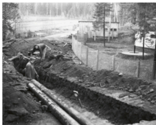
Mustalammen porjavedenottamon vesijohtotyö vuonna 1949.
