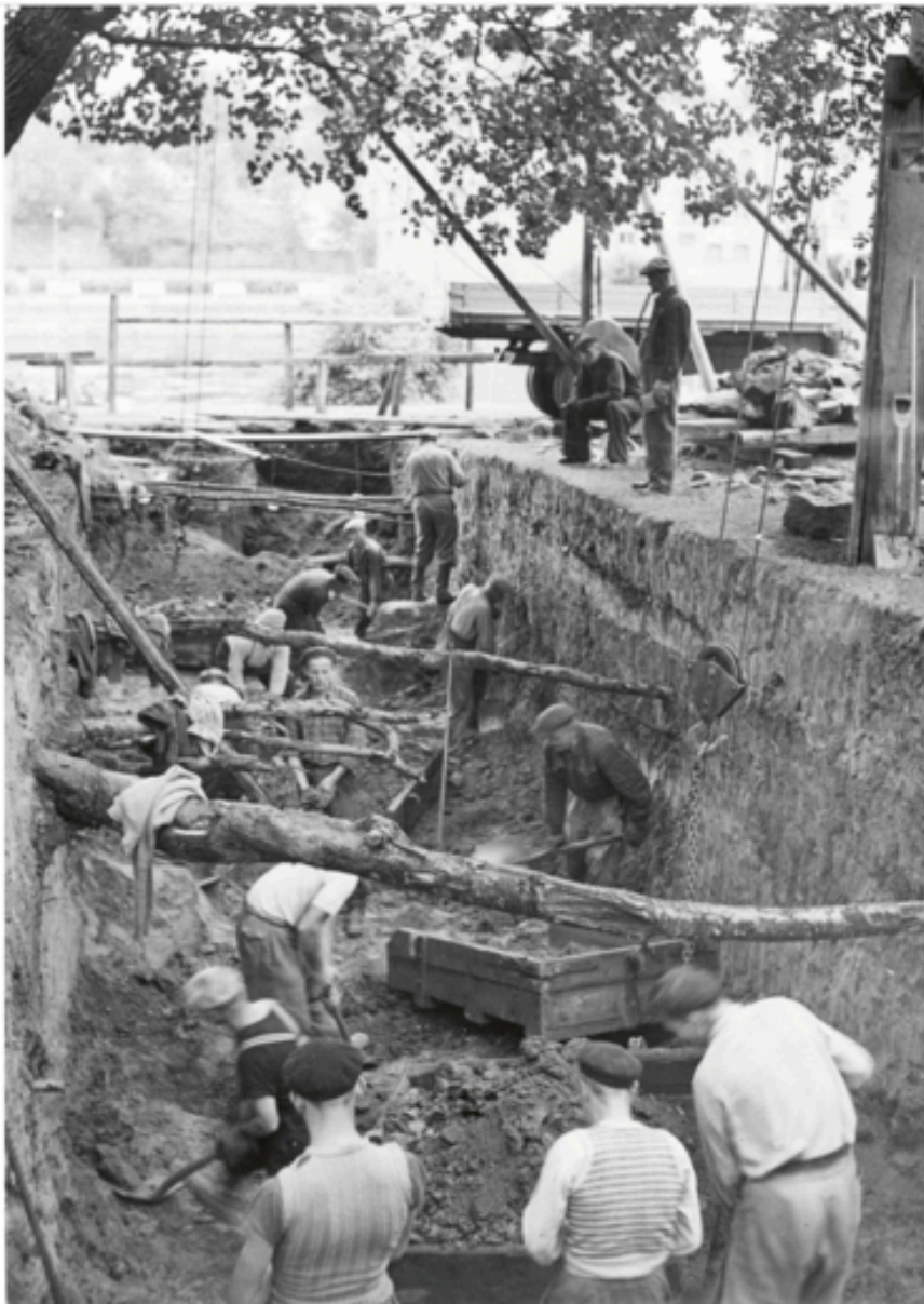
Viemäryömaa Koskipuistossa vuonna 1954.
