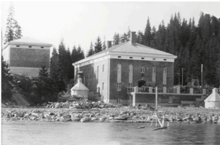
Kaupinojan pumppuaseman yleisnäkymä 1920-luvulla.
